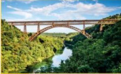
**Doc. 1** Pont métallique avec une structure treillis.
